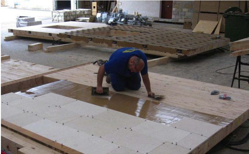
En el caso de revestimiento pegado, el material utilizado es un adhesivo de un solo componente elástico (disolvente)-Sikabond-T52FC-que también actúa de pantalla impermeable. La madera laminada encolada debe tener una humedad entre 10 y 15% para una perfecta aplicación del adhesivo.
